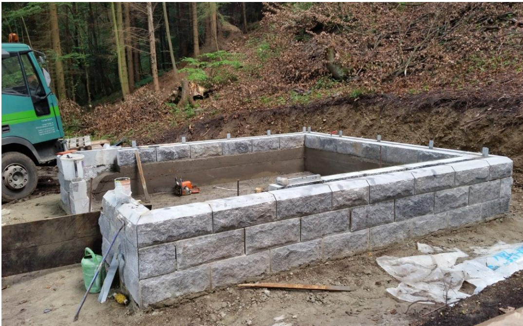
Der Sockel für die Basisstation des Waldbiwaks im Küllstedter Grund ist fertig, Quelle: Stefan Sander
